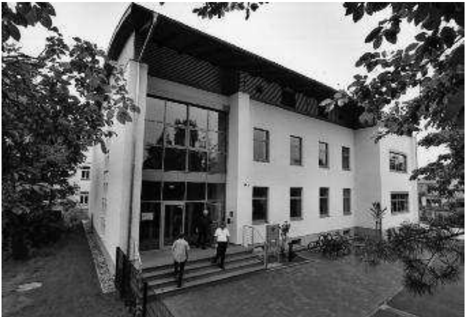
Abb. 1: Nordansicht des neuen Archivgebäudes, Haupteingang
