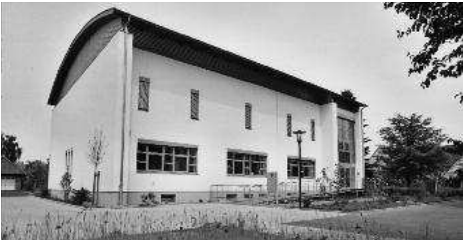
Abb. 4: Südansicht des neuen Archivgebäudes, Magazinräume im Obergeschoß
